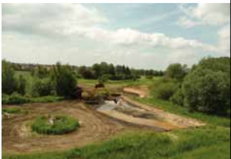
Bauarbeiten an der Schunter 2010
