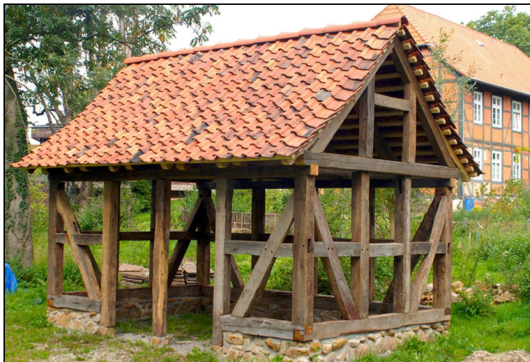
Das aus alten Materialien gebaute Fachwerkhäuschen - noch ohne Lehmwände
