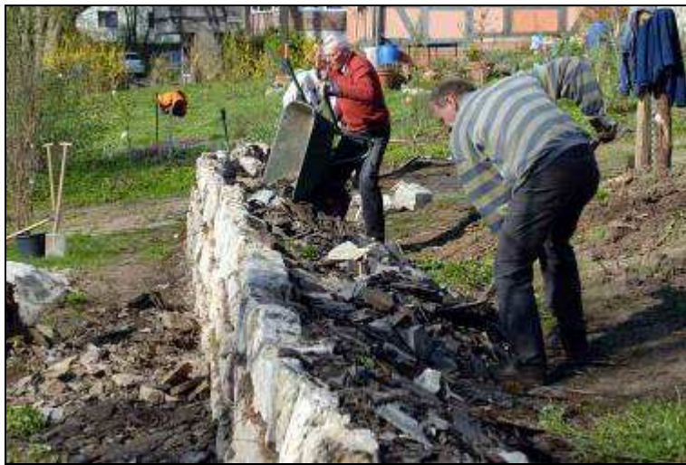
Bau der Natursteinmauer - Hinterfüllung mit Mergel
